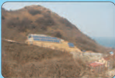
大连三山岛军队某部光伏发电自限温蓄能地面辐射及生活用电项目
